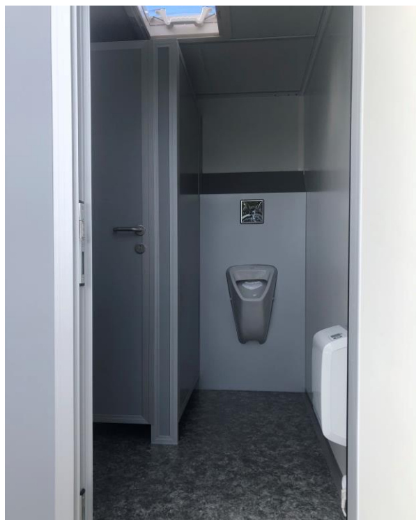
Herren WC mit Pissoir, Heizung
