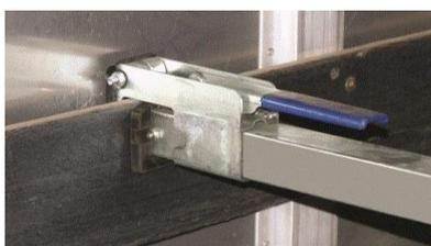
**Klemmlatte aus Stahl verzinkt (Sperrlatte)**
