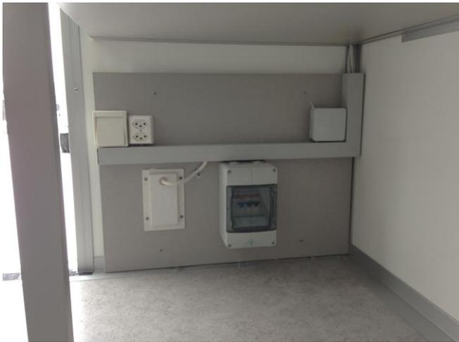
Stromverteiler 230V mit Steckdosen
